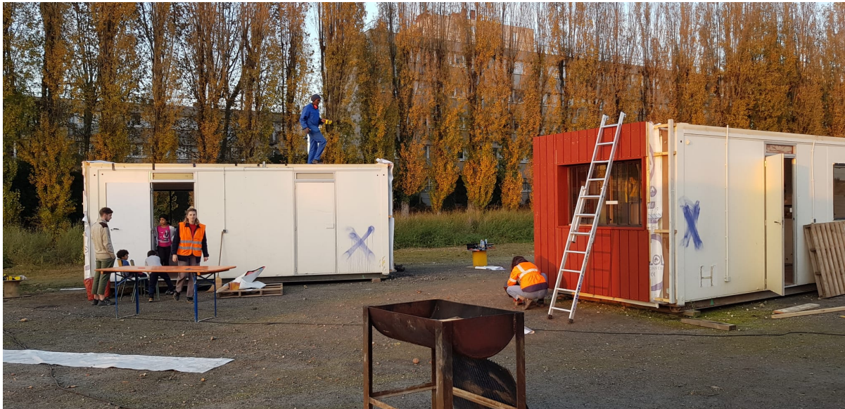
Chantier de bardage des Algeco avec le collectif Çavapu, Bagneux, automne 2021
